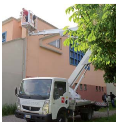
Una fase dell'installazione delle telecamere
